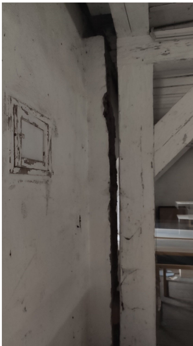
12 – pomaknut vanjski zabatni zid prema van
