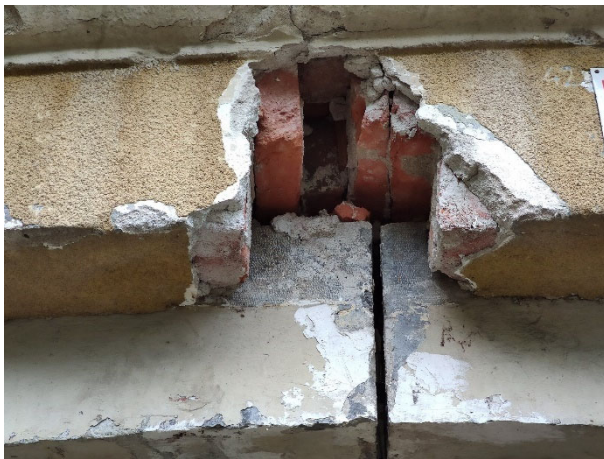
1 – oštećenje nadvoja na zabatnom zidu
