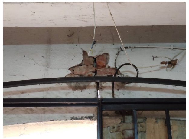
1 – oštećenje nadvoja na zabatnom zidu
