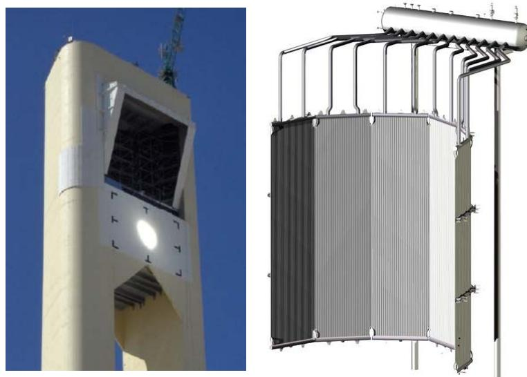
Slika 9.69.: Sabirnik smješten u šupljem kućištu tornja
