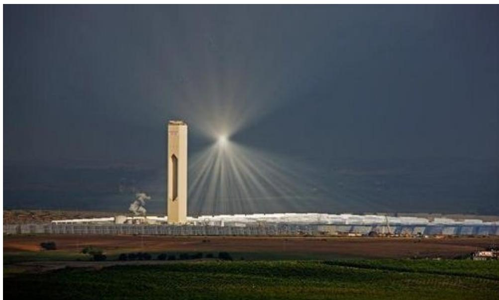
Slika 9.74.: Žarište heliostata odmaknuto od solarnog sabirnika
