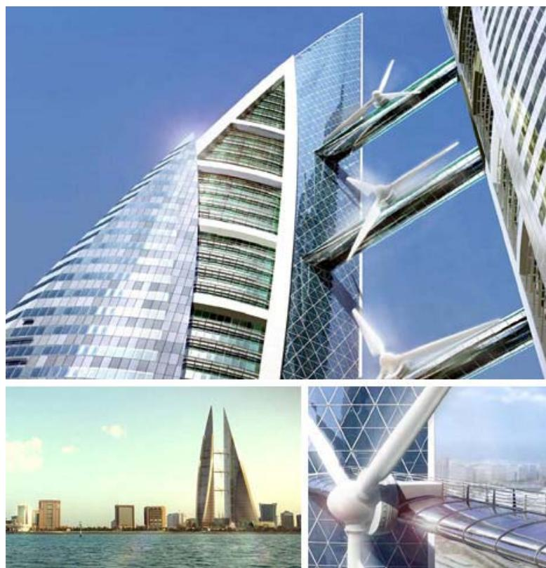
Slika 10.6.3. Prva građevina s instaliranim vjetroturbinama
