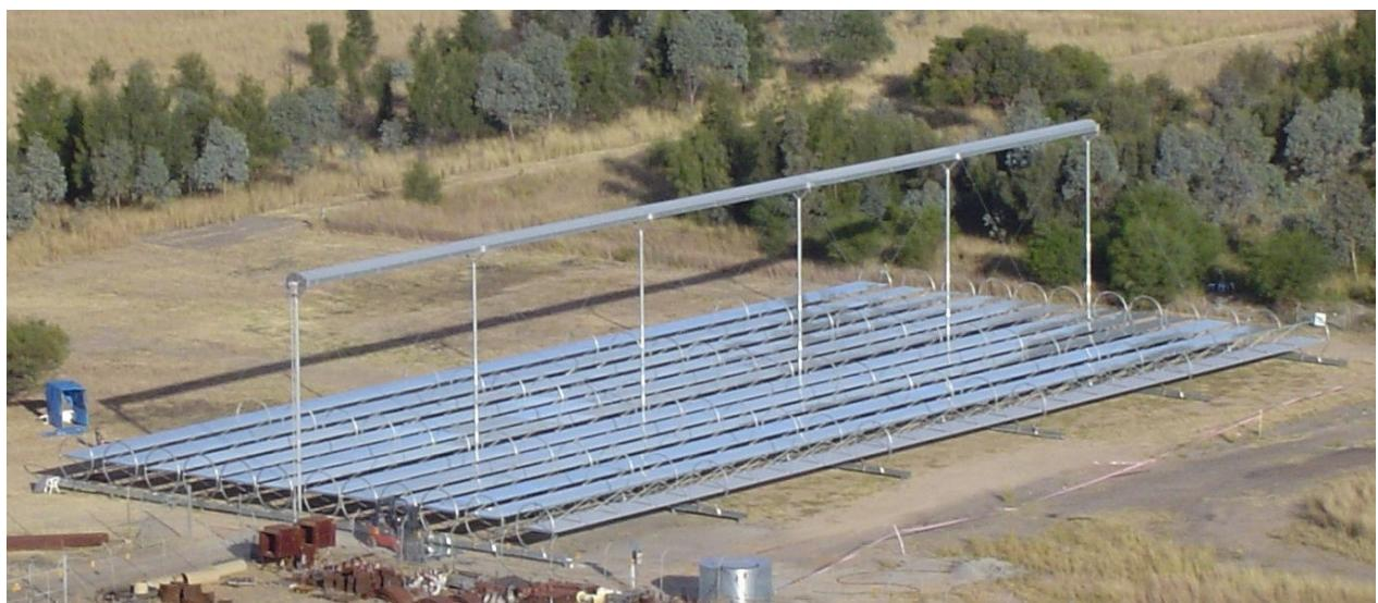
Slika 9.79.: Solarna termoelektrana s Fresnelovim reflektorima
