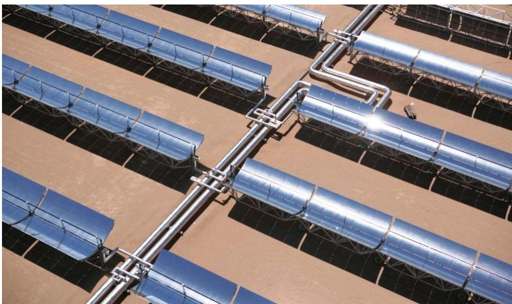
Slika 9.46.: Raspored cjevovoda s centralnom dobavom
