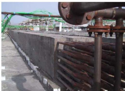
Slika 9.20.: Indirektni toplinski spremnik (termičko ulje/beton)
