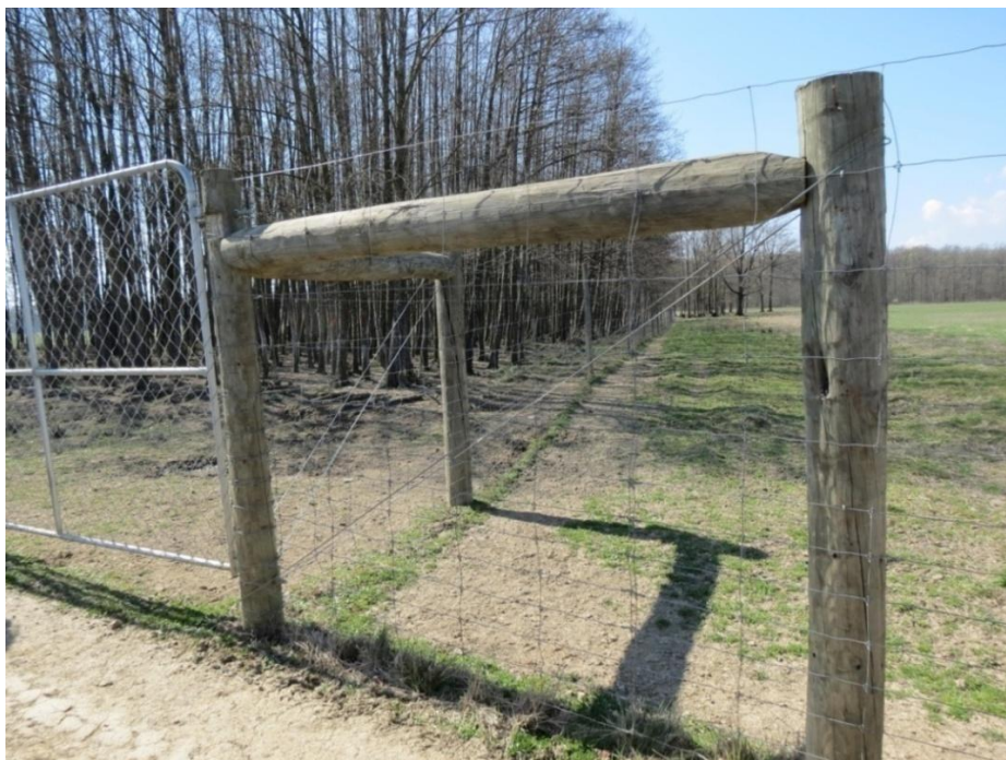
Slika 2–5. Pojačanje kutnog stupa (foto: N. Fabijanić)
